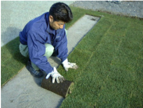
写真7：隙間なくソッドを張って行きます
